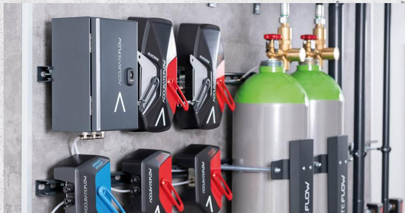
Gaslöschanlagen sind spezielle Feuerlöschsysteme, die einen Brand durch den Einsatz von gasförmigen Löschmitteln bekämpfen. Dabei erfolgt die Löschung entweder durch Sauerstoffverdrängung, also die Reduktion des Sauerstoffgehaltes, oder durch physikalische Effekte wie Wärmeentzug. Diese Art der Brandbekämpfung kommt insbesondere in Bereichen zum Einsatz, in denen Wasser, Schaum oder Pulverlösungen ungeeignet wären und der Einsatz dieser Löschmittel zu erheblichen Schäden führen könnte.
